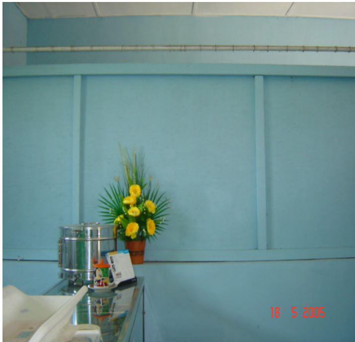
Kondisi dinding semi permanen di RS. X (tipe D)
